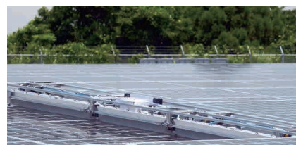
大型洗浄機※（工期：2日間/MW）
