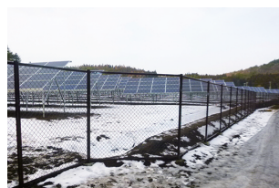
フェンス設置
