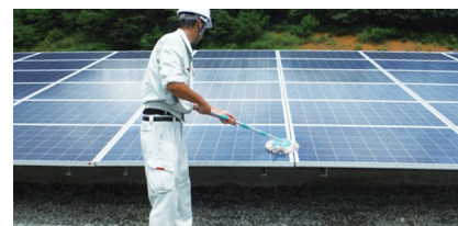
人工洗浄（工期：5～6日間/MW 4人/日）
