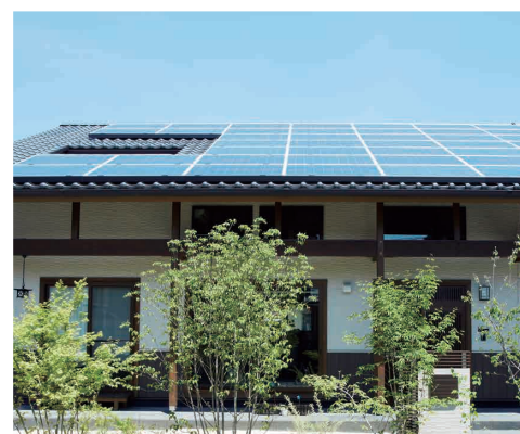
住宅屋根 栃木県宇都宮市 / 10.32kW
