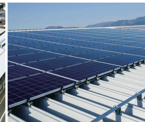
折板屋根 滋賀県長浜市 / 49.92kW
