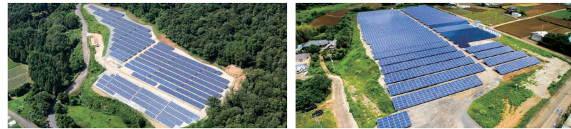
京都府福知山市 設置容量：1.8MW
