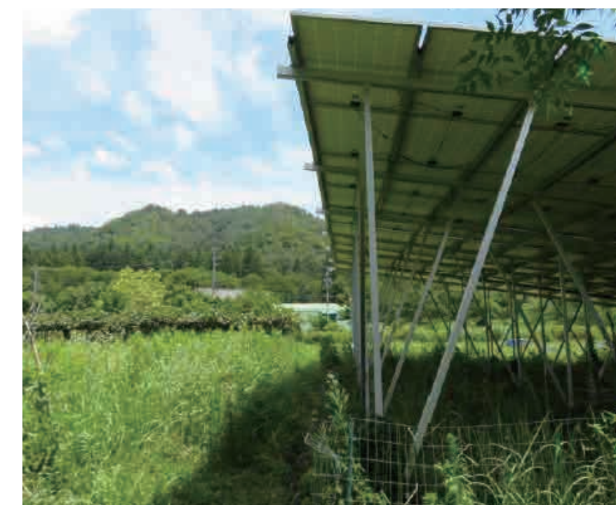
岐阜県 | DC 67.1kW / AC 49.5kW
