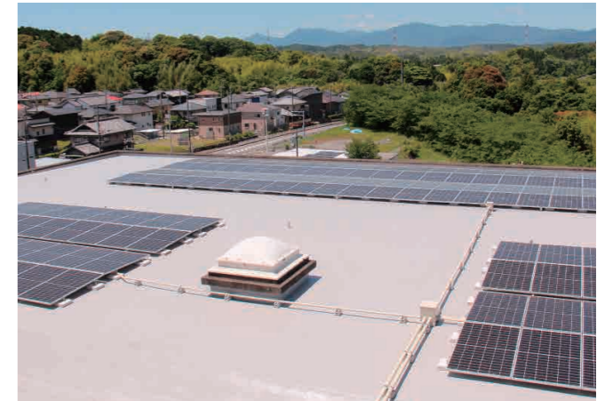
発電容量：72.96kW | 桑名市 多度まちづくり拠点施設 所在地：三重県桑名市
