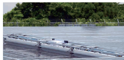
大型洗浄機*（工期：2日間/MW）
