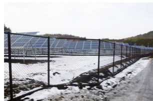
フェンス設置
