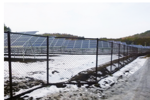
フェンス設置
