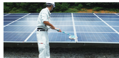
人工洗浄（工期：5～6日間/MW 4人/日）
