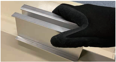
① 専用金具裏面に両面テープを貼り、接着剤を塗布したら、墨出し位置に配置
