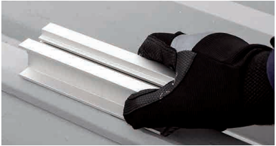
① 専用金具裏面に両面テープを貼り、接着剤を塗布したら、墨出し位置に配置
