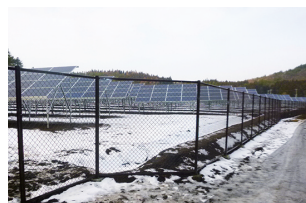
フェンス設置
