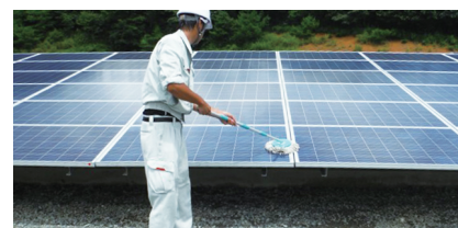
人工洗浄（工期：5～6日間/MW 4人/日）
