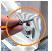
**ドリルビスを使用し、「支柱」と「架台ベース」を共締めすることで、スリップを防ぐ**
