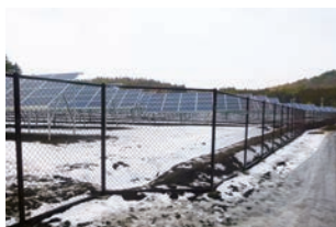
フェンス設置
