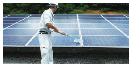
人工洗浄（工期：5～6日間/MW 4人/日）
