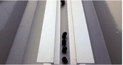
② 金具をしっかりと屋根面に押し付け接着する
