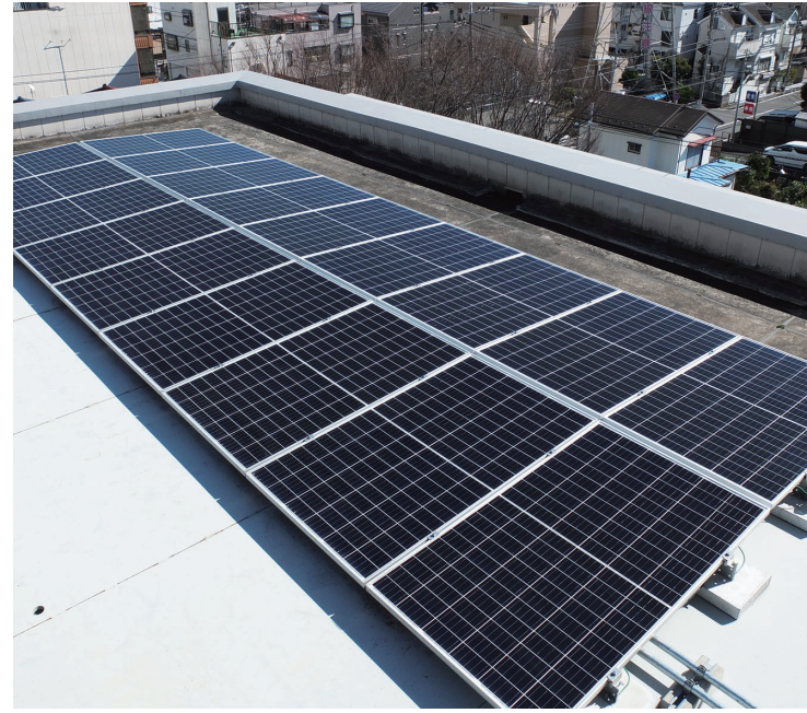
<X-3> 一般企業：東京電力技術開発センター （システム容量 9.9kW）
