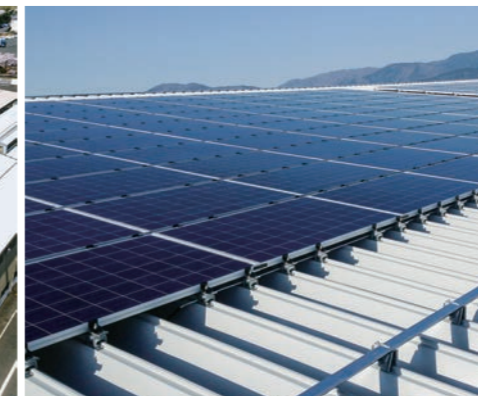
折板屋根 滋賀県長浜市 / 49.92kW
