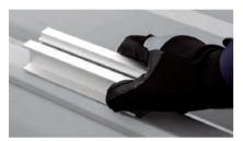
● 専用金具裏面に両面テープを貼り、接着剤 を塗布したら、墨出し位置に配置
