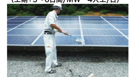
人工洗浄 (工期：5～6日間/MW 4人/日)
