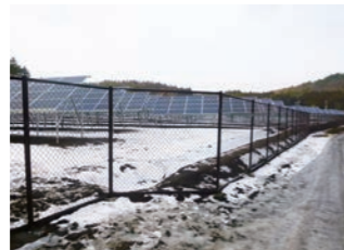
フェンス設置
