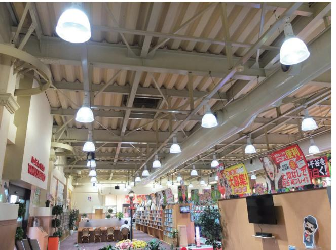
屋根の外側に遮熱処理を施し、水銀灯の照明をすべて LED に取り換えたことで、空調の効果が高まり使用電力量が削減された。
