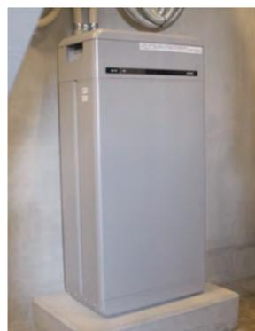
屋内に設置された蓄電池。停電時など非常時の防災用電源として活用できるだけでなく、日常的な電気購入量の削減にも貢献する。
