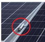
風荷重に負けて押え金具が変形
