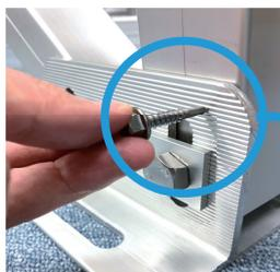
「支柱」と「架台ベース」を友締め出来る場所に、ドリルビスをネジ込み、固定する。反対面も同様に固定する。
