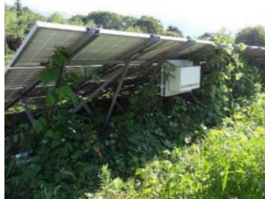
雑草が多く、火災の危険性あり
