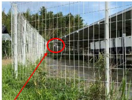
一般者から確認できない位置にある標識。
