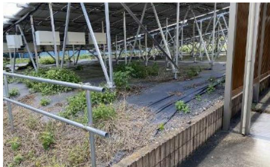
フェンスの一部なし、あっても下から容易に侵入可能
