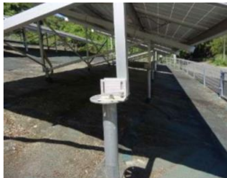
杭基礎がGL700mm程度出ており、 架台取付も全てずれている
