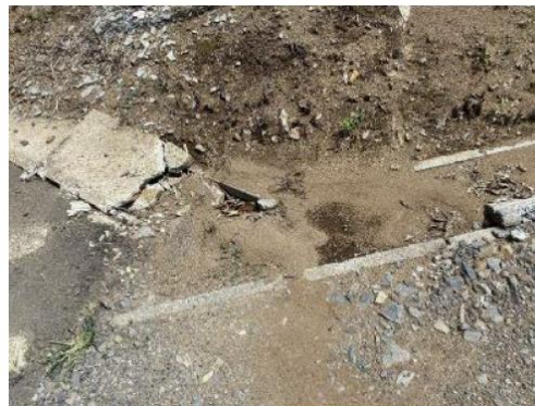
排水溝が完全に埋まり、土砂が流出
