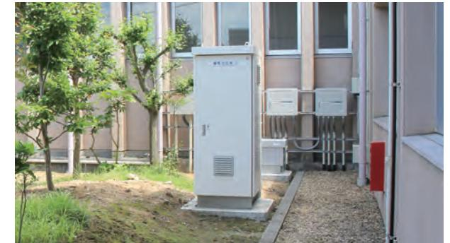
屋外に設置された蓄電池。万が一の停電時に電気を使えるようにするだけでなく、日常的な電気購入量の削減にも貢献している。
