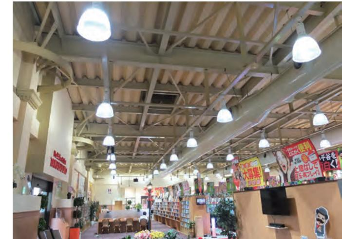
屋根の外側に遮熱処理を施し、水銀灯の照明をすべて LED に取り換えたことで、空調の効果が高まり使用電力量が削減された。
