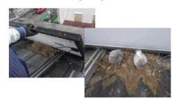
太陽発電モジュールと屋根の間にハトが巣を作ってしま うケースがあります。ハトの羽、巣材などがケーブルに絡 まるなどして故障の原因にもなります。
