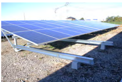
手順① アレイの前に土台石を設置して縦レールをアレイの基礎と土台石に固定
