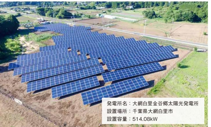
太陽光発電による売電で、安定的に収入を確保できることに魅力を感じていた施主様は、1年前から導入を検討していました。少しでも収益性を高めるために、初期投資を抑えることを重視した提案をいたしました。その一つが大容量パワーコンディショナを使用せず、中型9台による分散設置です。この設計は初期投資を抑えるだけでなく、トラブル時の対応がしやすいので、万一の事態が発生しても損失を抑えることができるメリットもあります。着工から完工に至るまでも、当社工事課の社員が事前の下調べから密に施主様とコミュニケーションをとっていたこともあり、信頼して任せただけました。
