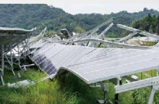
モジュールが飛散しただけでなく、架台から崩壊してしまった発電所
