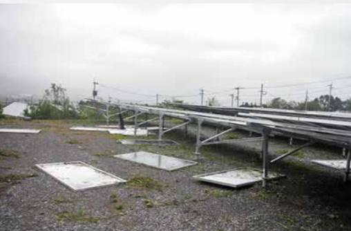
台風15号によりモジュールが飛散してしまった発電所
