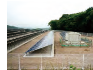
群馬県高崎市に2013年5月に完工した500kWの発電所(P06写真)。 高崎第一発電所 / 株式会社岸土木様
