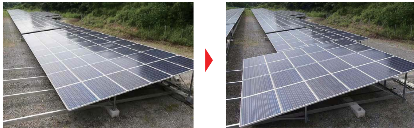
基礎にアレイをスライドさせるためのレールを固定
