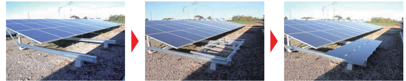
① アレイの前に土台石を設置して、縦レールをアレイの基礎と土台石に固定
