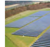
ドイツに建設されたメガソーラー
