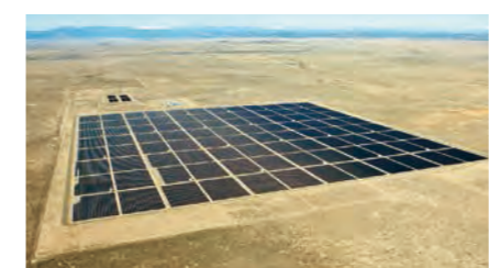
アメリカ北部の広大な砂漠地帯に建設されたメガソーラー
