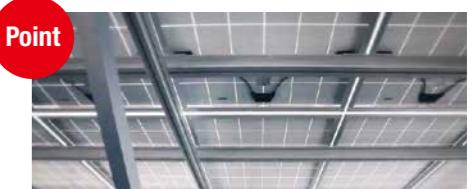
XSOL RACKは、結束バンドやサドルなどで固定する作業が不要な、横レールの内部に延長コードが通せる設計となっています。ケーブルを傷つける心配なく、設置後のケーブル保護機能も兼ね備えます。
